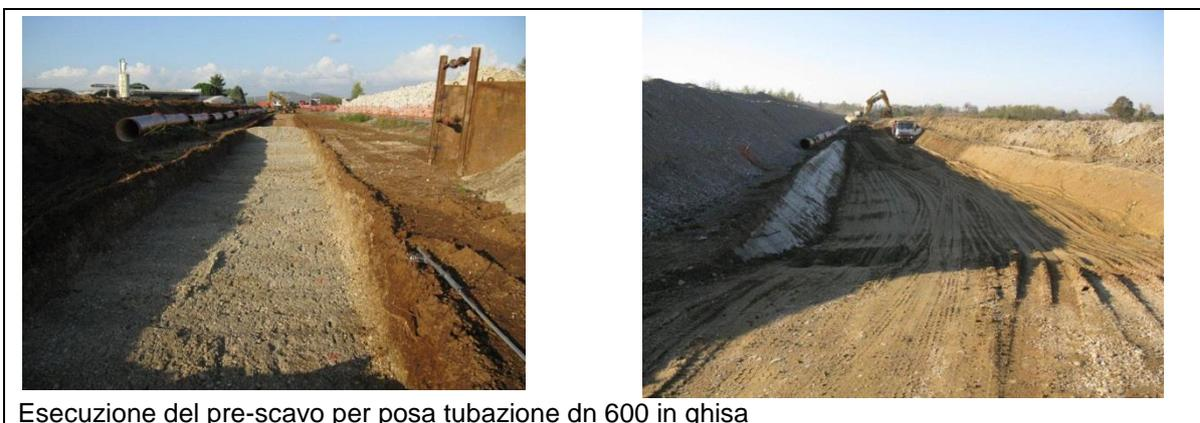
Esecuzione del pre-scavo per posa tubazione dn 600 in ghisa
