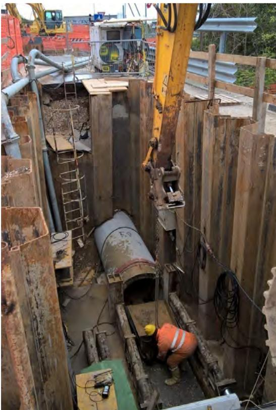
**Fossa di spinta a guida laser per l'attraversamento del raccordo ferroviario del Branco**
