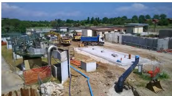
**Lavori di realizzazione del comparto dei pretrattamenti compatti: demolizione parti esistenti e realizzazione collegamenti idraulici**
