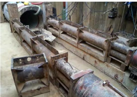
**Dettaglio del meccanismo di spinta a guida laser per l'attraversamento della linea ferroviaria VE – TS**
