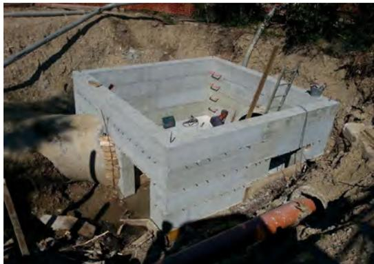
**Pozzetto di ripartizione della portata realizzato a monte della linea ferroviaria VE – TS**
