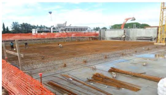
**Vasca di sedimentazione: posa in opera dell'armatura della platea e del sistema di aggancio alle fondazioni**
