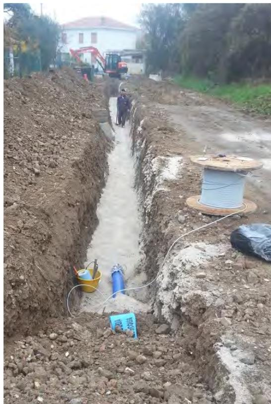
**Fasi della posa della condotta di acquedotto in via San Vito in sostituzione della vetusta condotta in fibrocemento**
