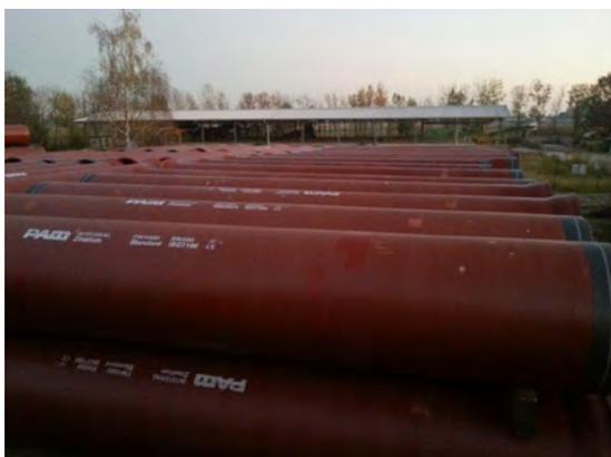
**Vista dell'area di stoccaggio delle tubazioni in ghisa sferoidale DN1000 (circa 210 tubi)**
