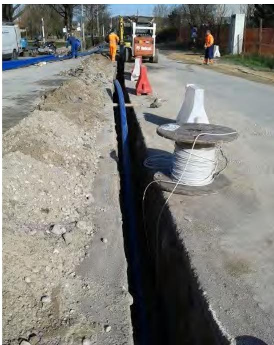
**Vista dello scavo per la posa della condotta lungo la via principale**
