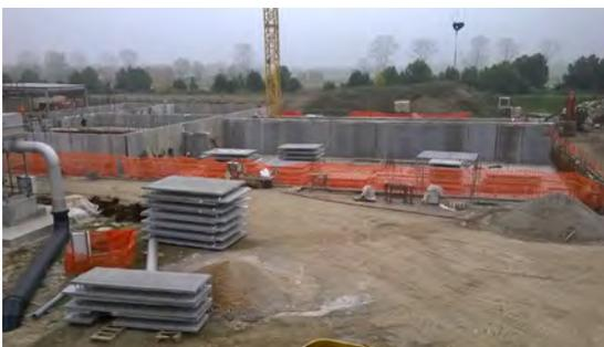
**Vasca di sedimentazione: posa delle ultime bilastre a completamento dei setti verticali**
