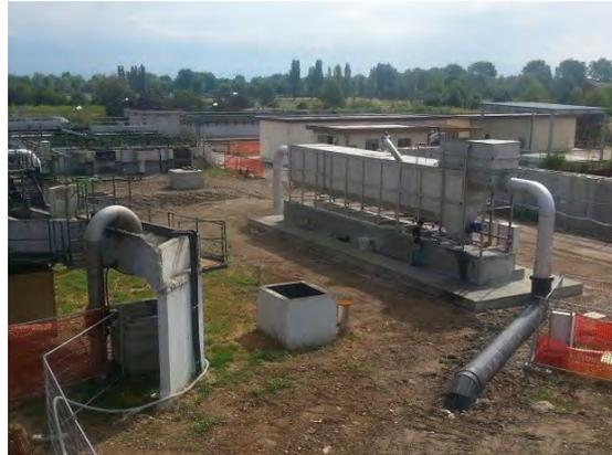
**Comparto dei pretrattamenti compatti: vista a fine lavori dell'apparecchiatura installata**
