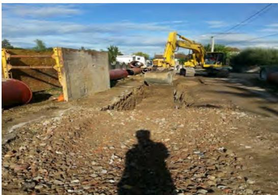
**Fasi della posa della linea fognaria in ghisa sferoidale in via San Vito**
