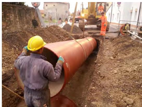
**Fasi della posa della linea fognaria in ghisa sferoidale in via San Vito**
