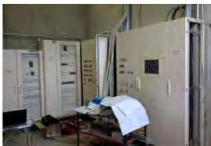
Fasi di installazione e collegamento dei quadri elettrici di potenza e comando del comparto biologico
