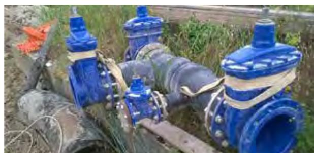
Sistema di valvole predisposto per un nodo della nuova rete di acquedotto
