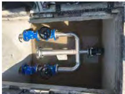
Pozzetto di mandata della condotta fognaria in pressione con flangia per ispezione e manutenzione / spurgo della condotta
