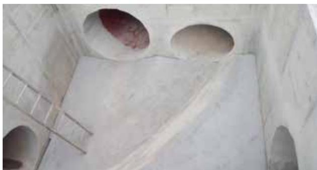
Pozzetto ripartitore di portata a valle della linea ferroviaria VE - TS: la sagomatura del fondo permette di deviare le portate di magra nella nuova condotta in ghisa sferoidale.
