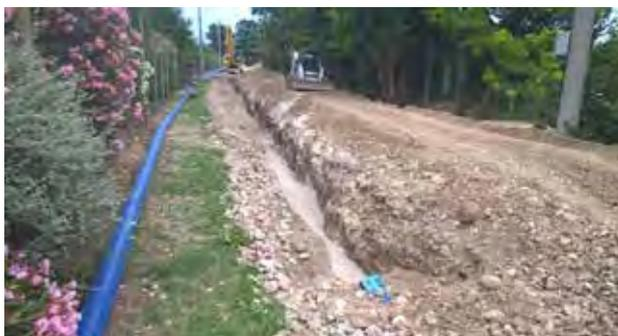
Posa della condotta di acquedotto in PEAD DE 160 mm in sostituzione della vetusta condotta in fibrocemento
