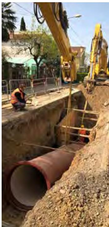
Posa delle tubazioni in ghisa sferoidale nell'abitato di San Vito
