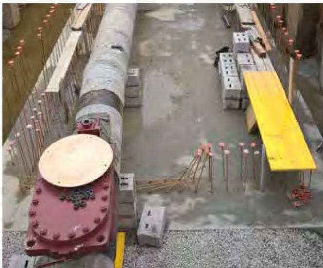
Vista dello scavo con palancole e messa in luce tubazione da 22"
