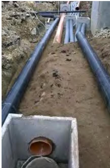
Fasi di realizzazione della rete di sottoservizi: si distinguono linee aria, cavidotti per impianto elettrico, rete di smaltimento acque meteoritiche.
