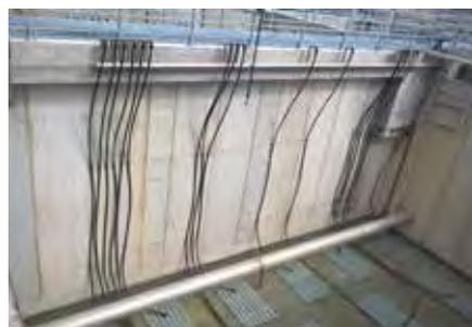
Posa delle piastre di aerazione del comparto di ossidazione e della rete di distribuzione dell'aria
