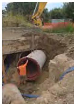
Sostituzione delle tubazioni esistenti in calcestruzzo DN1200 effettuata in corrispondenza del cavallotto esistente della tubazione di acquedotto DN1500
