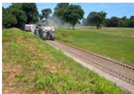
Consolidamento mediante fresatura e miscelazione con cemento della strada bianca di accesso al depuratore
