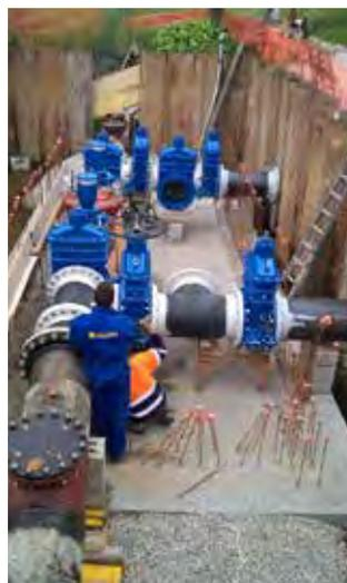
Alcune fasi delle lavorazioni e struttura idraulica (quasi completa) posata
