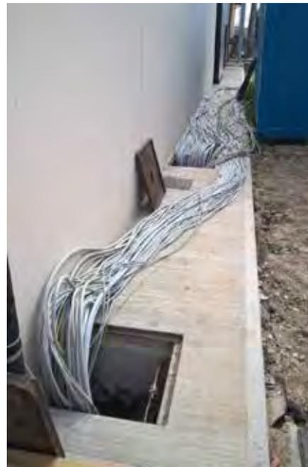
Fascio di cavi in corso di posa presso l'edificio soffianti
