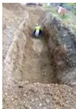
Fasi della posa della linea fognaria in ghisa sferoidale a valle della linea ferroviaria VE - TS
