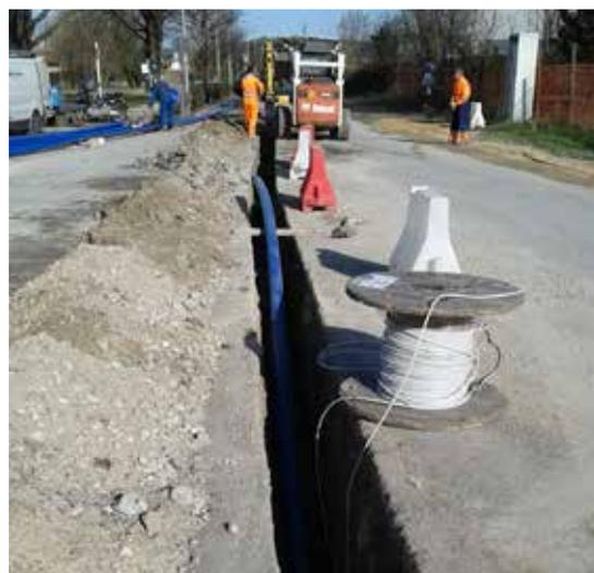
**Vista dello scavo per la posa della condotta lungo la via principale**
