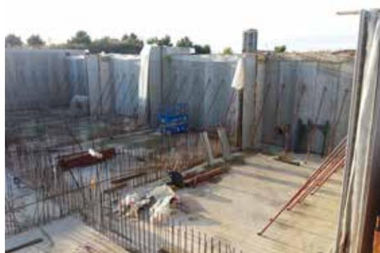
**Fasi di costruzione della vasca di ossidazione – Posa delle bilastre per la realizzazione delle strutture in elevazione**
