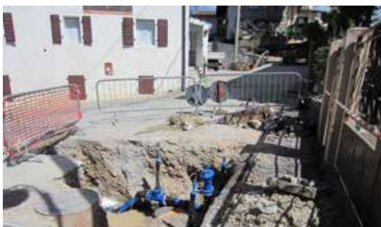
**Particolare del nodo della rete di acquedotto realizzato a Scriò (insieme di valvole e idrante)**
