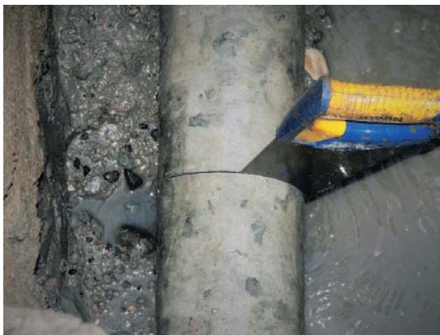
Figura 6 - Taglio di una tubazione mediante seghetto manuale (Inail Dit).
