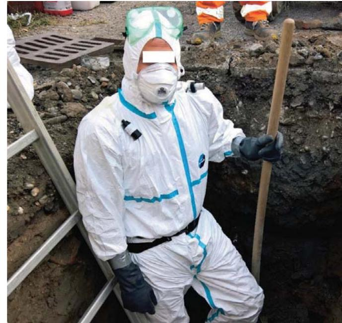
Figura 12 - Operatore con appositi Dispositivi di protezione individuale.
