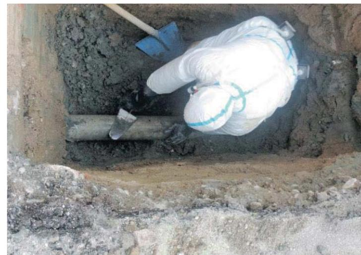
Figura 14 - Messa a giorno delle tubazioni in cemento amianto mediante attrezzi manuali.
