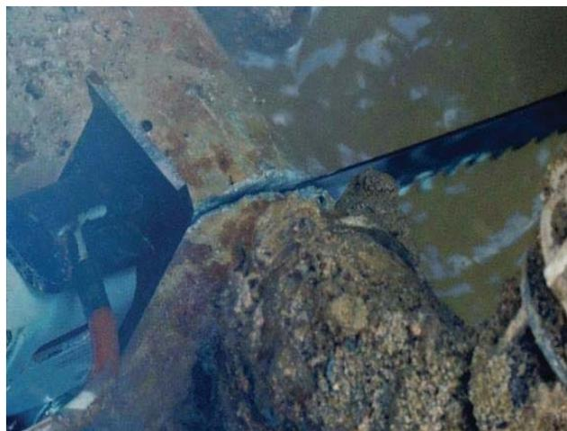
Figura 7 - Taglio di una tubazione mediante seghetto alternativo a motore (a scoppio) a bassa velocità di rotazione.
